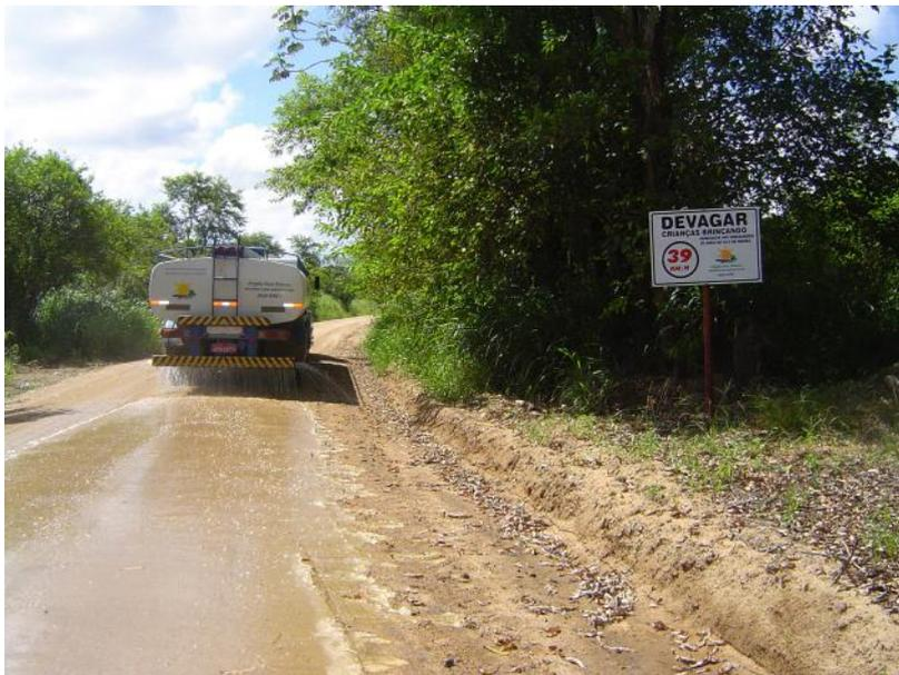
Caminhão-pipa molhando a estrada com água captada do sistema de reúso
