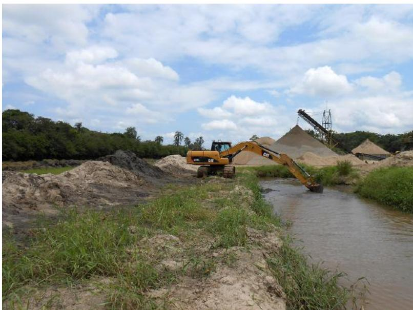
Limpeza do decantador, água utilizada no reúso
