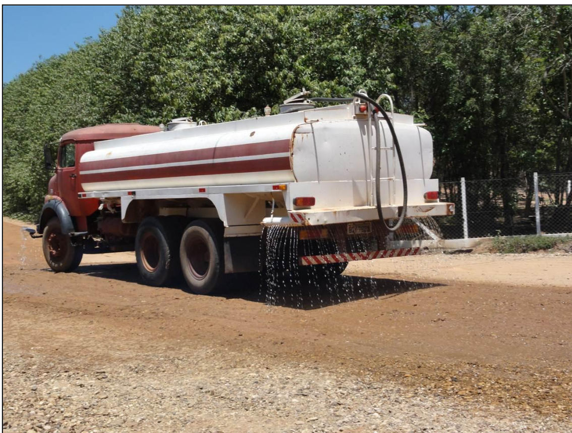
Foto 8 - Umidificação dos acessos internos do empreendimento para controle de poeira.
