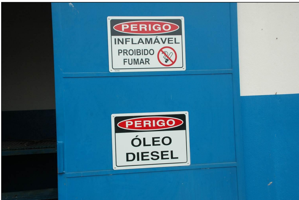
Foto 19 - Área de estocagem de óleo diesel devidamente isolada e identificada por placas.
