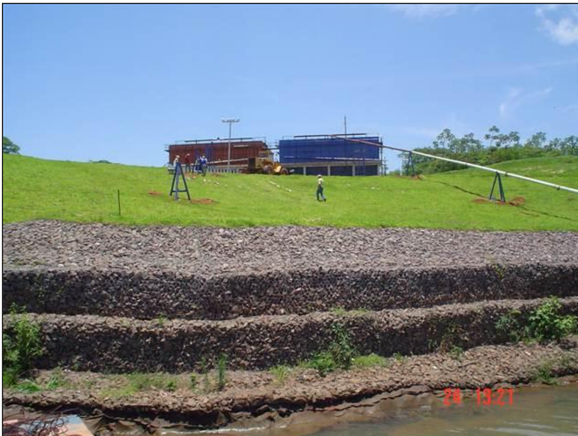
Foto 7 - Proteção das margens com gabião
