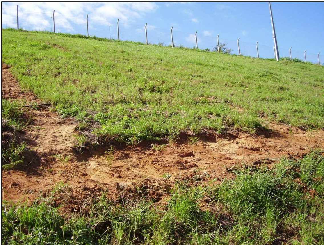
Foto 5 - Proteção dos limites do empreendimento com cerca de arame e retaludamento com gramíneas.
