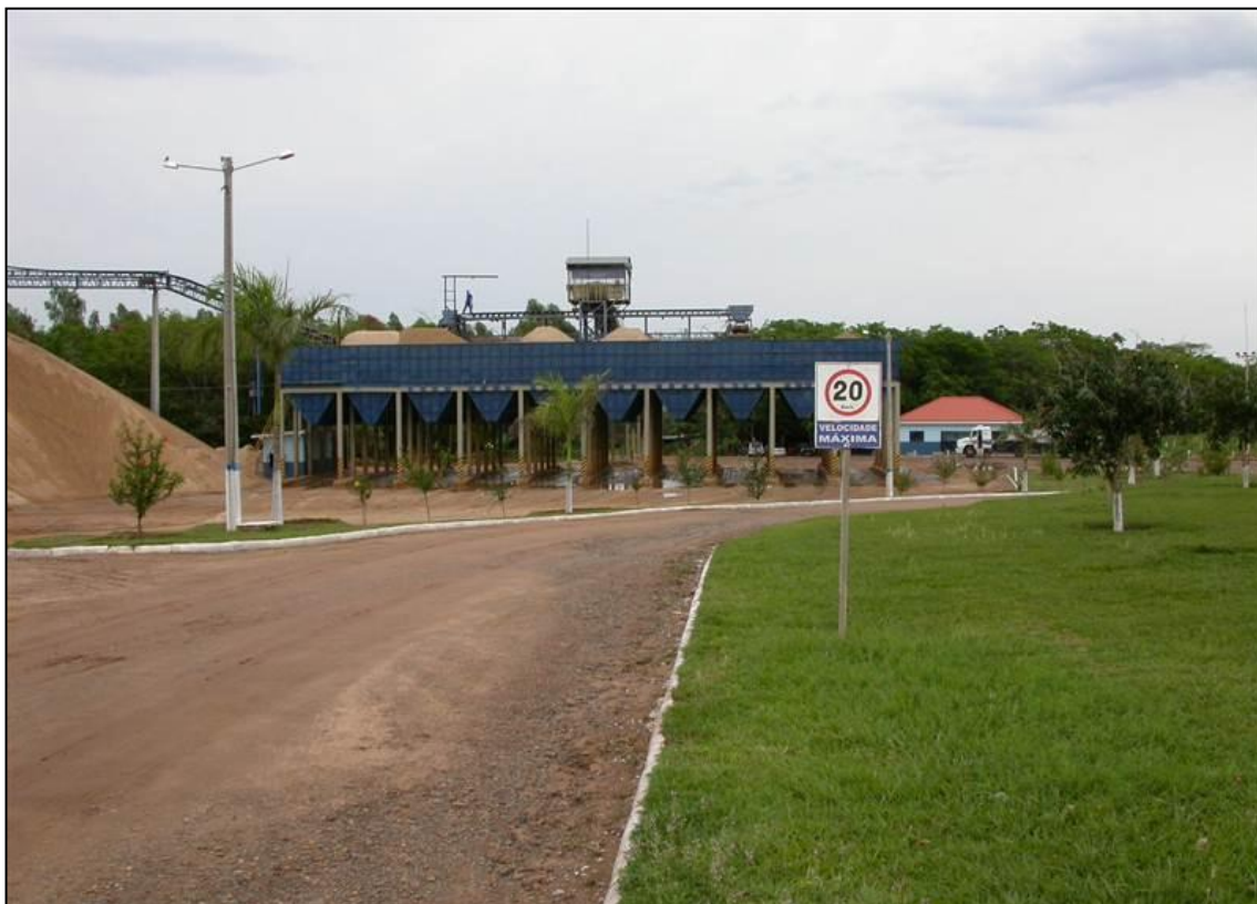
Foto 3 - Outro exemplo de limitador de velocidade nos acessos do empreendimento.
