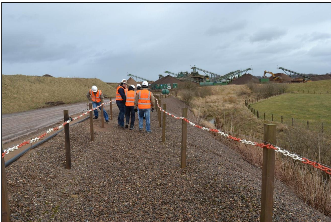
Foto 17 - Calçada de acesso à área operacional do empreendimento (notar acesso de máquinas á esquerda da calçada de acesso).
