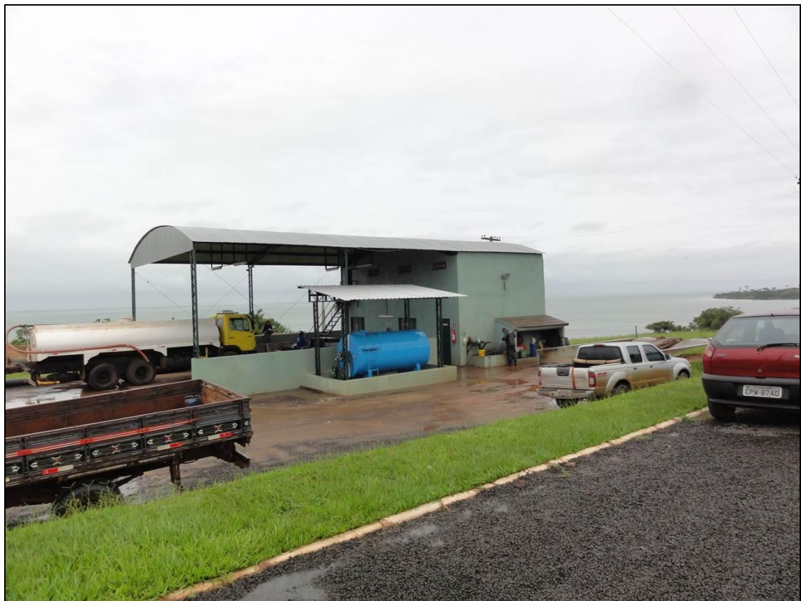
Foto 25 - Oficina e tanque de combustível, devidamente isolados e protegidos.
