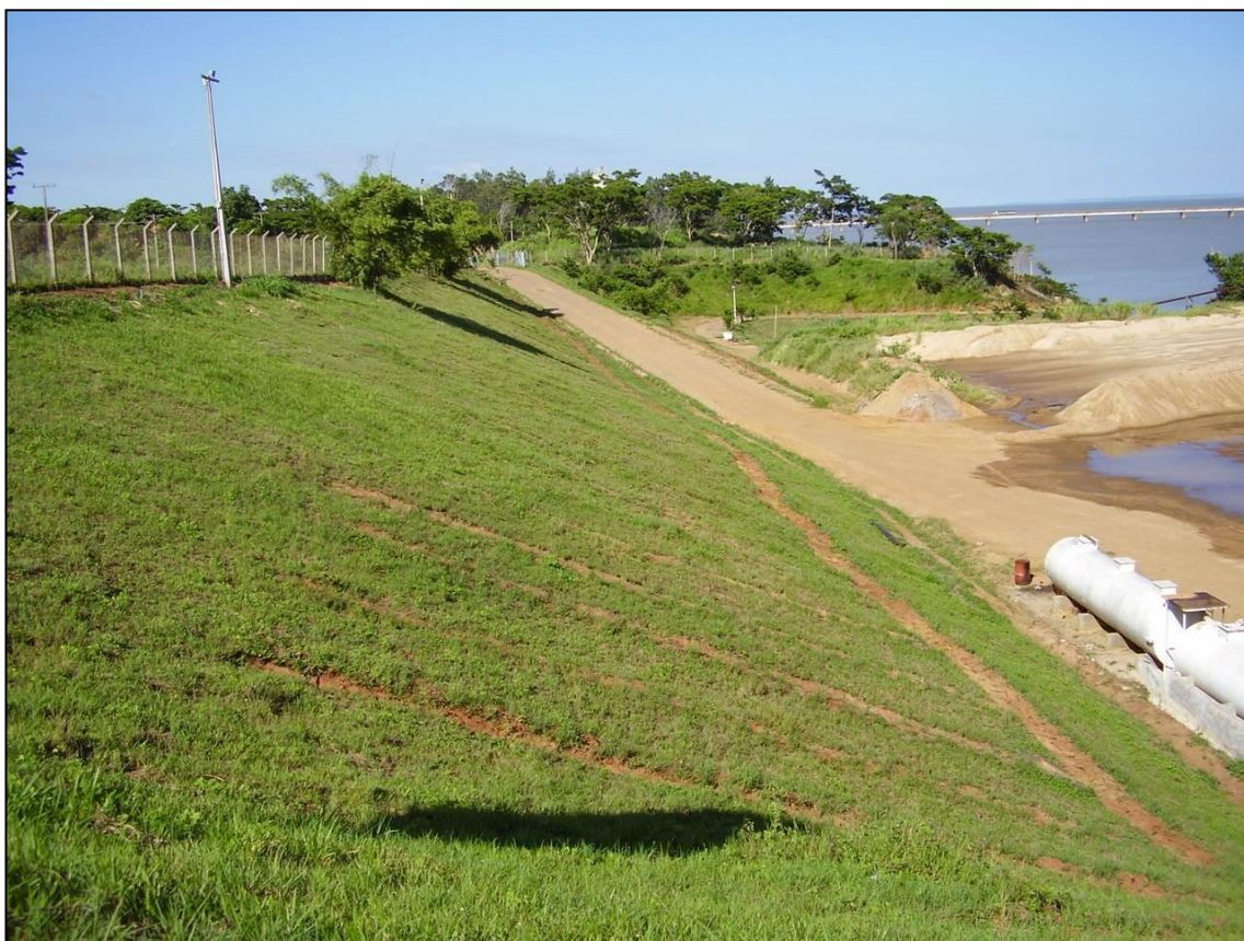
Foto 6 - Vista em perfil do retaludamento com gramíneas.
